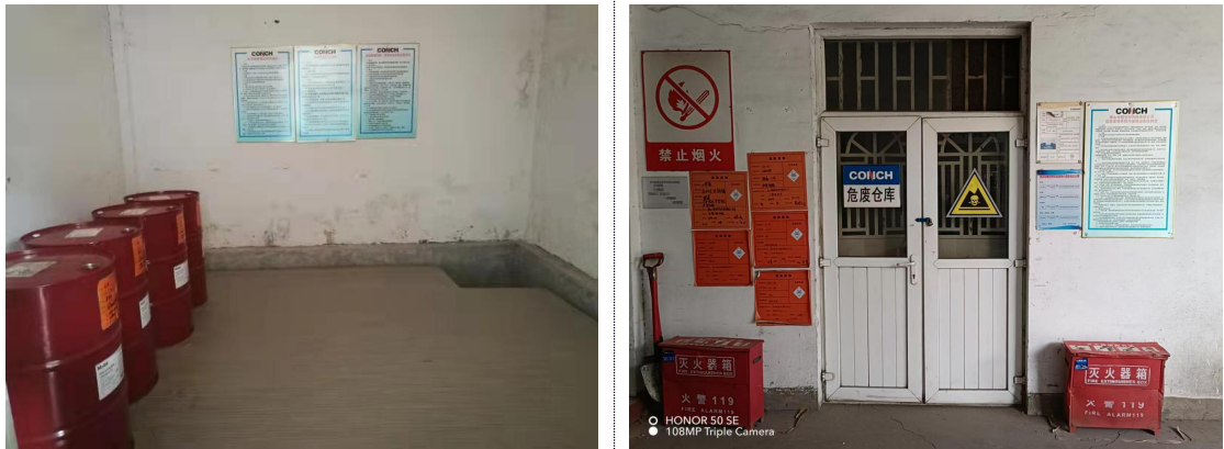
图 10 危险废物暂存间现状情况
